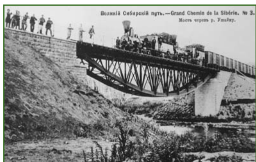
Рис. 10 Мост через реку Ушайку
