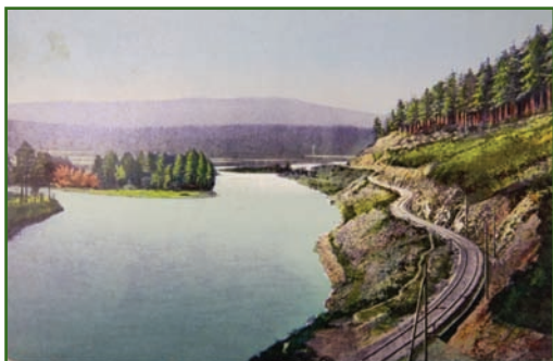
Рис. 8 Полотно железной дороги на берегу реки Хилка на 339 версте
