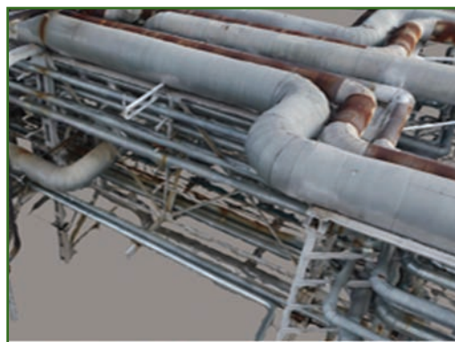
Рис. 3 3D модель участка эстакады, полученная по результатам лазерного сканирования и данным фотограмметрической обработки
